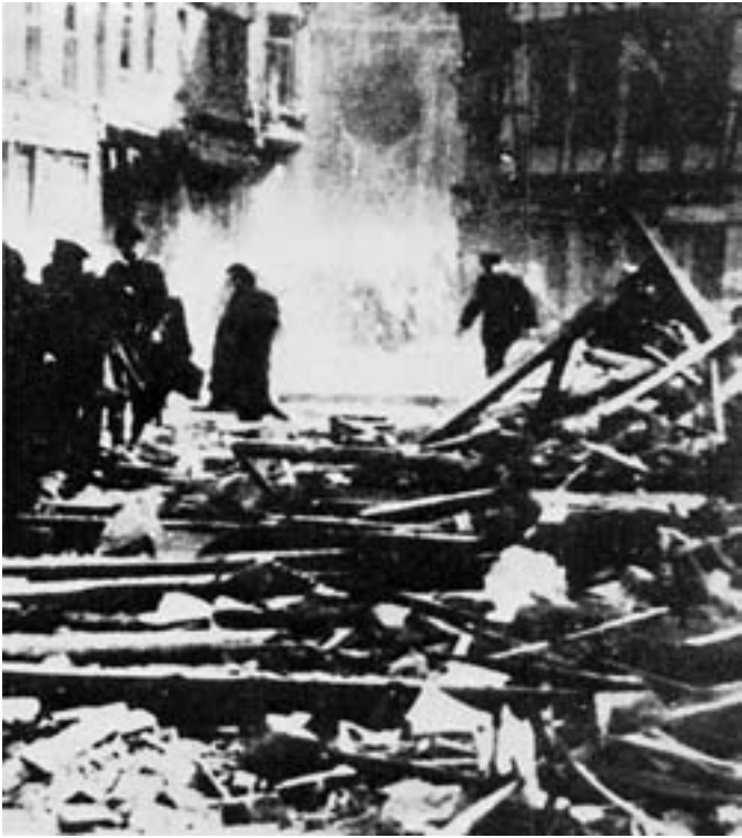
Nr. 3: Eingang Schmiedestraße.
